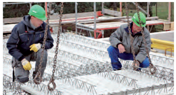
► Montaż elementów betonowego sufitu w Berlinie-Spandau
