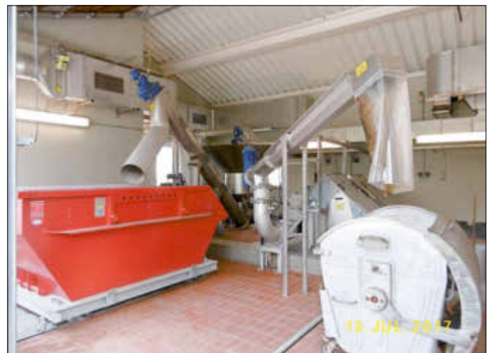
Feinrechenanlage und Sandwäscher Fotos: Städtische Abwasserbeseitigung Forst (Lausitz)
