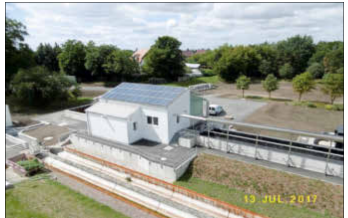
Maschinenhaus mit Sand- und Fettfang
