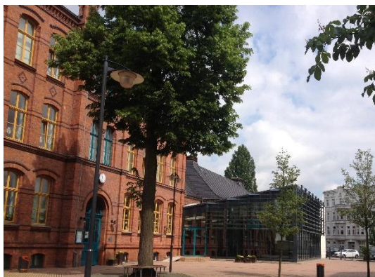
Denkmalgeschütztes Schulgebäude Grundschule Nordstadt und neuer Zwischenbau
