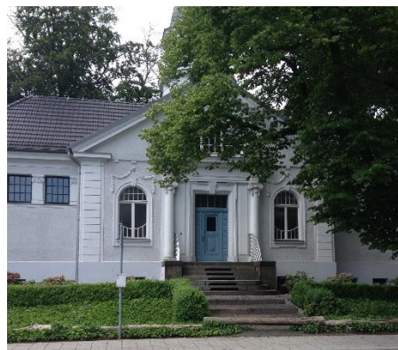
Denkmalgeschütztes Gebäude - Kompetenzzentrum in der Gubener Straße 30a
