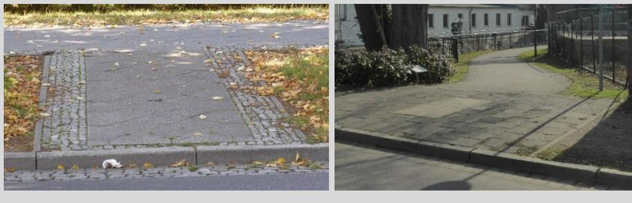
Abbildung 3.51: Fehlende Bordabsenkung an der Bahnhofstr. (links) und an der Parkstr. (rechts)
