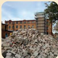
Nachdem im Hauptgebäude alle Zwischenwände entfernt und Leitungen sowie technische Anlagen demontiert waren, kamen die originalen Strukturen der denkmalgeschützten Textilfabrik Noack wieder zum Vorschein.
