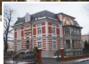
Villa Rüdigerstraße 12; Foto: Herwarth + Holz (2014)
