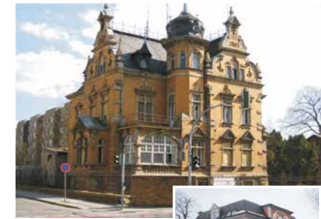
Villa Rüdigerstraße 10, Foto: Herwarth + Holz (2014)
