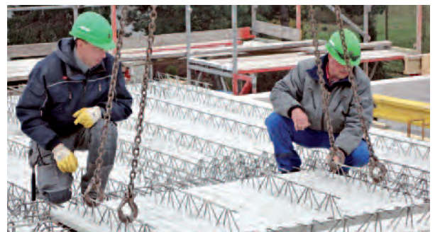
► Montaż elementów betonowego sufitu w Berlinie-Spandau
