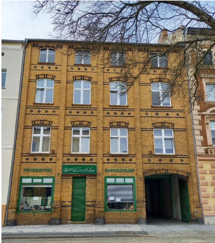
Abbildung 3: Gemischte Nutzung in der Bahnhofstraße 24
