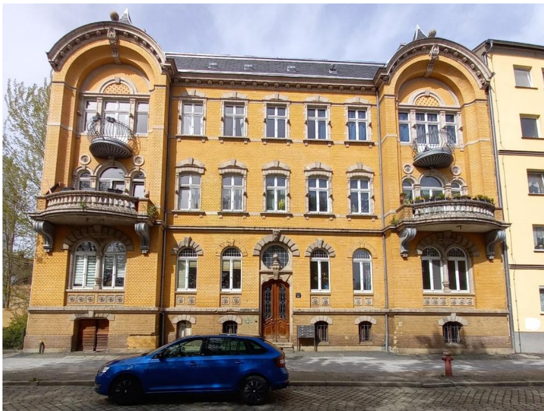
Abbildung 5: Aufwändige Fassadengestaltung Sorauer Straße 14
