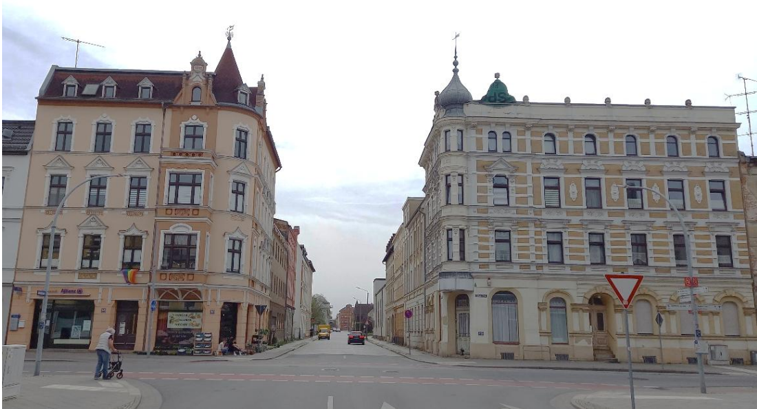
Abbildung 6: Eckbebauung Cottbusser Straße 56 u. 58
